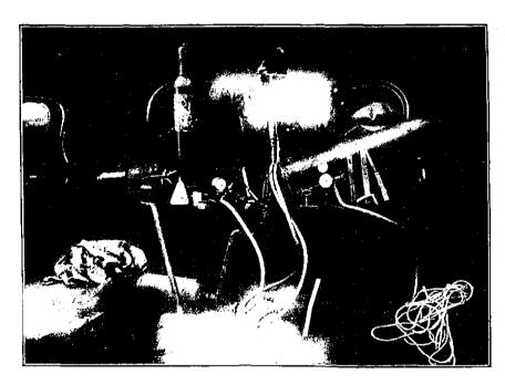
Outillage complet pour percer les coffres-forts au chalumeau oxydrique.
